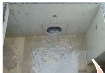
暗渠からの排水状況
