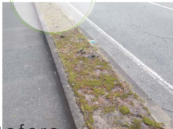
道路の植樹帯
