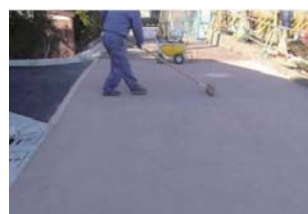
アステスソイル敷き均し状況
